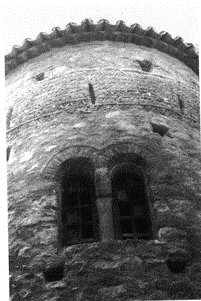
Fig. 14 - Chiesa della Panaghia di Rossano, abside (f. Venoso)
