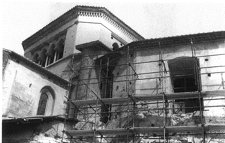
Fig. 6 - SBAAAS-CS - Archivio fotografico, neg. n. 40237, lato absidale - lavori di demolizione, 23 settembre 1982.
