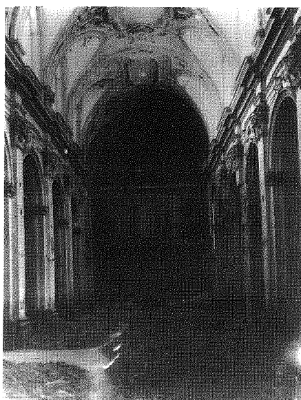
Fig. 1 - SBAAAS-CS, Archivio fotografico, neg. n. 319, navata centrale prima del ripristino, data incerta.
