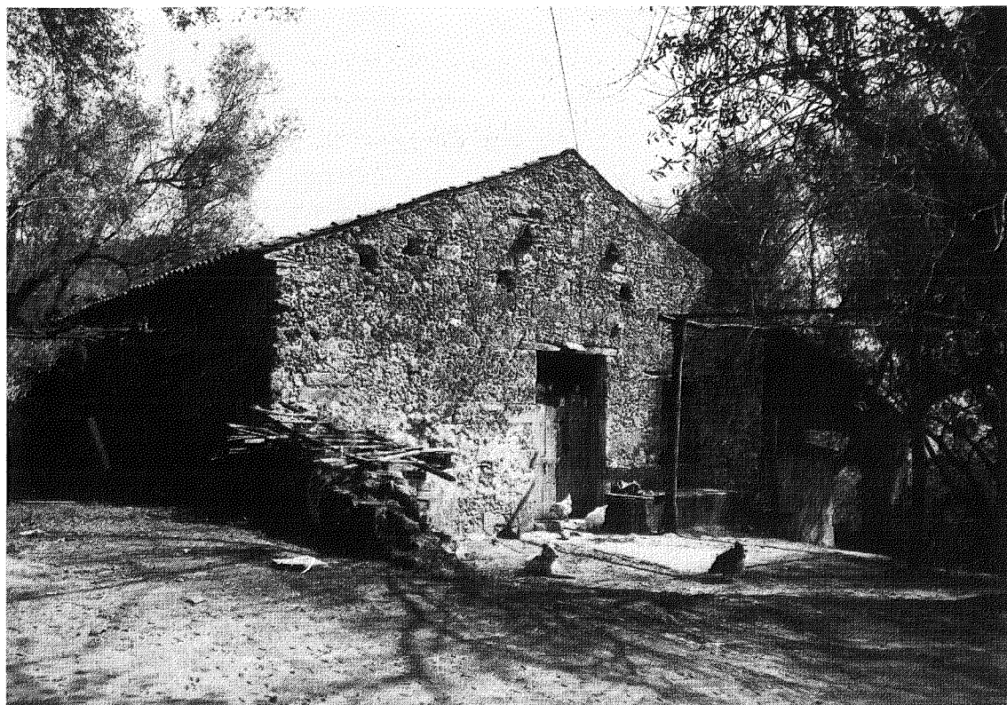
3. - 4. San Calogero. Contrada Santopoli. Casa rurale edificata nel secolo scorso sui ruderi del convento.
