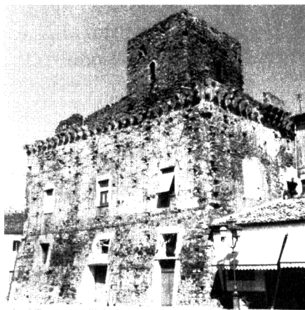
Fig. 4 Terranova di Sibari (CS). Veduta del torrione inglobato nelle strutture di fine XV- XVI secolo.
