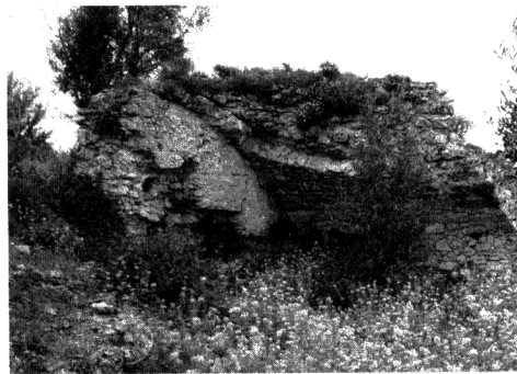
Fig. 20 Gerace (RC). Particolare dell'ambiente coperto a volta.
